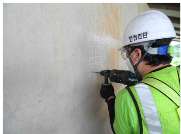
탄산화깊이 측정 현황
